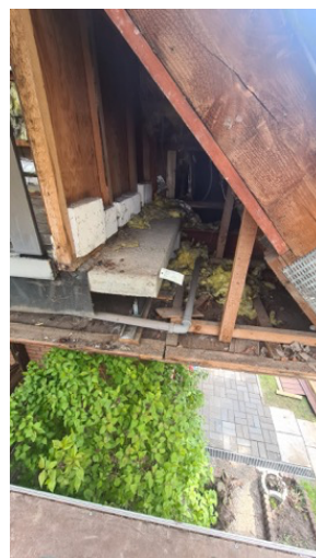
Die Balkonseite vor der Sanierung: Wegen gravierender Wasserschäden mussten die Giebel des Hauses in Norderstedt erneuert werden. Ein Marder hat das Holzständerwerk so stark geschädigt, dass die Giebelbekleidung komplett erneuert werden musste. Im Zuge der Giebelsanierung wurde auch gleich die Dämmung optimiert. Fotos: Sven Heyer/Harm Juraschek
