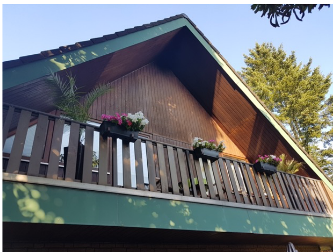
Die Balkonseite vor der Sanierung: Wegen gravierender Wasserschäden mussten die Giebel des Hauses in Norderstedt erneuert werden. Ein Marder hat das Holzständerwerk so stark geschädigt, dass die Giebelbekleidung komplett erneuert werden musste. Im Zuge der Giebelsanierung wurde auch gleich die Dämmung optimiert. Fotos: Sven Heyer/Harm Juraschek
