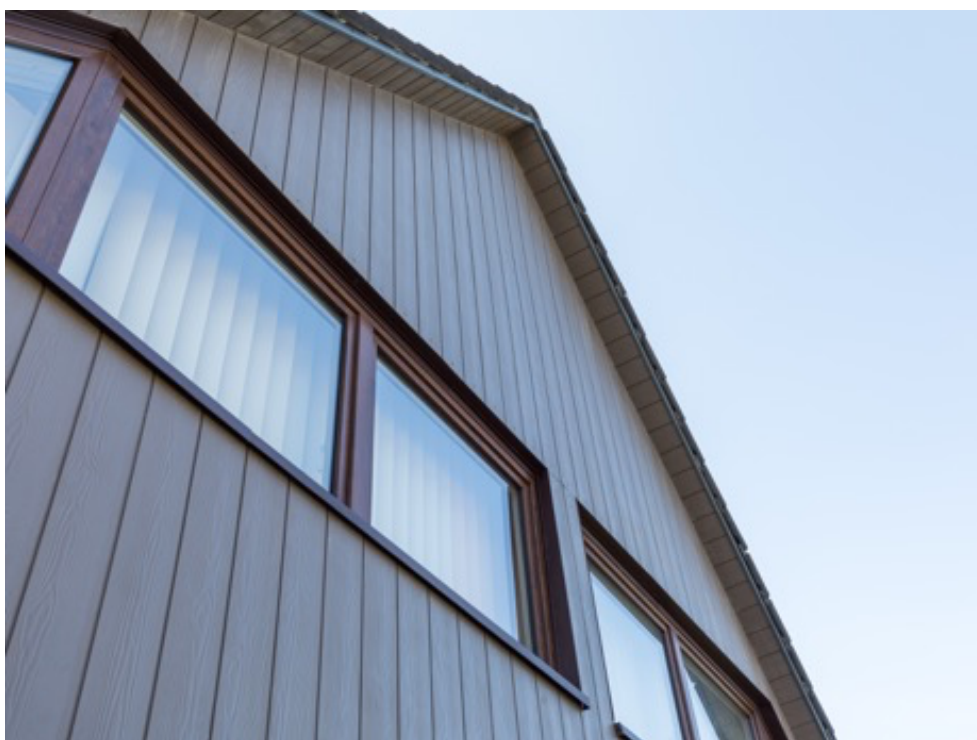
Die Fassadenkante schließt mit einem Außeneckprofil sauber ab.
