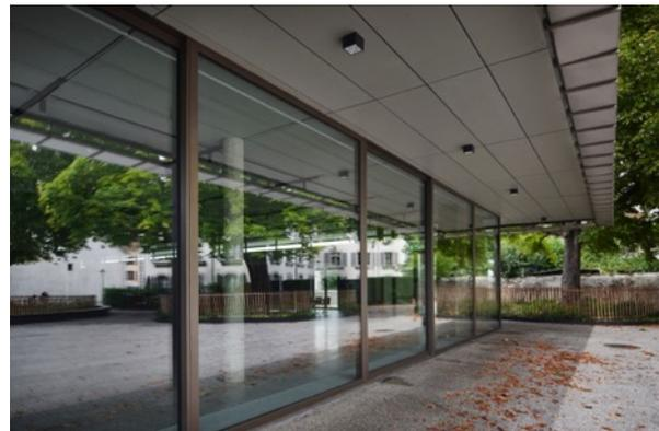
*Eine ästhetische und technische Verbindung zwischen Bestand und Neubau: Die Türen und Festverglasungen wurden sowohl im Theatergebäude (links im linken Bild) als auch im benachbarten Festsaal mit dem Stahlprofilssystem forster unico realisiert.
