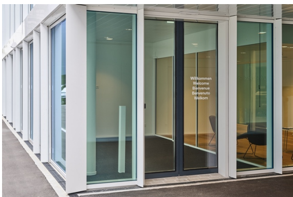
Im Eingangsbereich des Bürogebäudes sorgt die eigens entwickelte Schiebetür forster unico mit Einbruchhemmung RC2 für eine offene Atmosphäre. Foto: © Thomas Hary
