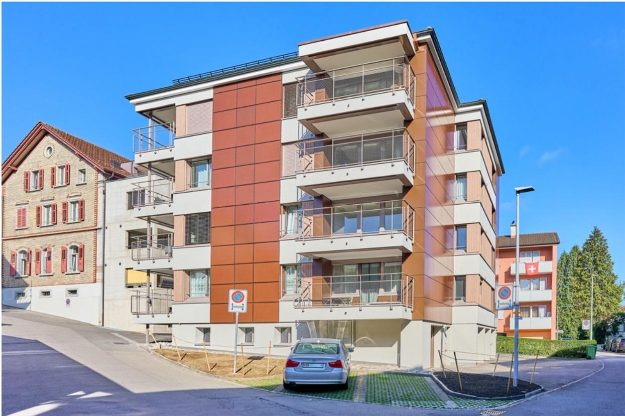
La couleur des modules photovoltaïques montés verticalement s'inspire de la façade d'origine en briques. Photo : 3S Swiss Solar Solutions AG
