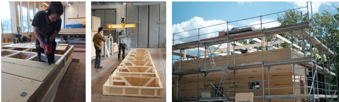
X4S – Extension for Sustainability, das Team der Hochschule Biberach setzt auf Holzfaserdämmung. Dank der modernen Holzbauweise mit hohem Vorfertigungsgrad und kurzen Bauzeiten vor Ort, war der Prototyp in wenigen Tagen aufgestellt. Fotos Team X4S
