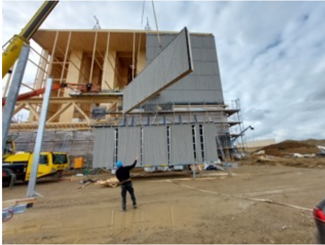
Die Holz-Wandelemente sind mit einer äußeren Dämmschicht aus 60 Millimeter starker Holzfaserdämmung GUTEX Pyroresist wall gedämmt. Foto: Michelgroup
