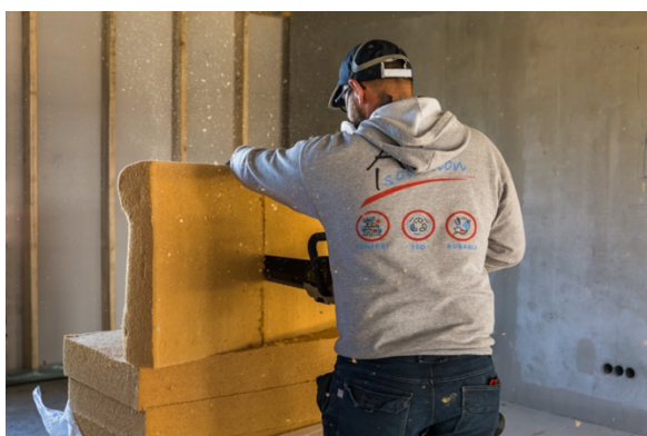
Nouvel écoquartier en cours de construction à Pau : habitat mixte et protection de l'environnement sont les piliers du projet de développement urbain durable dans le quartier de « Laherrère ». L'isolation des bâtiments d'une surface utile totale de 11 000 mètres carrés est réalisée avec des panneaux isolants en fibres de bois de GUTEX. Fin du chantier prévue début 2023. Photos : GUTEX
