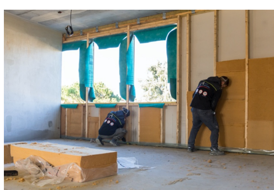
Nouvel écoquartier en cours de construction à Pau : habitat mixte et protection de l'environnement sont les piliers du projet de développement urbain durable dans le quartier de « Laherrère ». L'isolation des bâtiments d'une surface utile totale de 11 000 mètres carrés est réalisée avec des panneaux isolants en fibres de bois de GUTEX. Fin du chantier prévue début 2023. Photos : GUTEX
