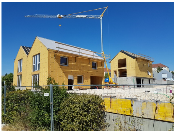
Construction de 40 logements à Dijon : grâce à une construction préfabriquée en ossature bois avec des panneaux isolants en fibre de bois de GUTEX, ce projet a pu être réalisé dans les meilleurs délais et répond aux exigences les plus élevées en matière d'efficacité énergétique. Photo : Habellis
