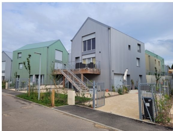
Construction de 40 logements à Dijon : grâce à une construction préfabriquée en ossature bois avec des panneaux isolants en fibre de bois de GUTEX, ce projet a pu être réalisé dans les meilleurs délais et répond aux exigences les plus élevées en matière d'efficacité énergétique. Photo : Habellis
