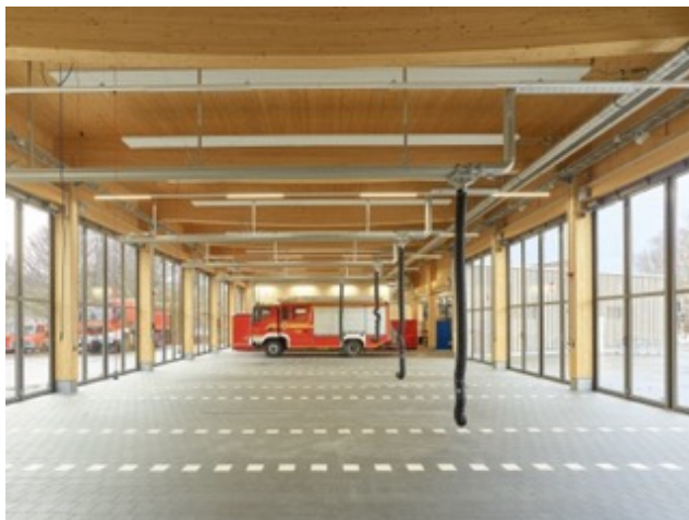
Das Tragwerk der Fahrzeughalle besteht aus Fischbauchträgern auf Holzstützen. Das im Gebäude verbaute Holz stammt aus zertifizierter, regionaler Forstwirtschaft im Schwarzwald und im Allgäu. Foto: Oliver Rieger
