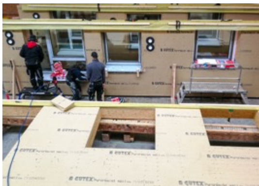
Vorfertigung im Werk: Die Firma Donaubauer Holzbau in Ingolstadt verarbeitete mehr als 4.000 qm schwer entflammbare, nichtglimmende Dämmplatten GUTEX Pyroresist wall. Foto: Donaubauer Holzbau
