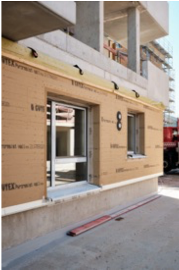
Die vorgefertigten Holzrahmenelemente sind mit der Holzfaserdämmplatte GUTEX Pyroresist wall ausgestattet. Die schwer entflammbare, nichtglimmende und putzbeschichtbare Dämmplatte eignet sich besonders für die Gebäudeklassen 4 und 5. Foto: Jonathan Sage
