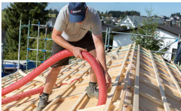
Mit GUTEX Fibrejet einblasbare Dämmstoffe sicher und komfortabel einblasen. © GUTEX
