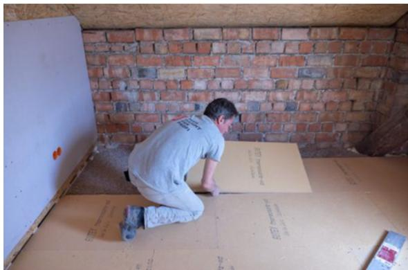
*In den Innenräumen wurden neue, holzfasergedämmte Trennwände eingezogen und auch alle Böden mit nachhaltigen Dämmstoffen realisiert.*
