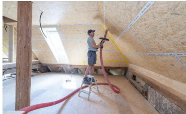
*Die alten Sparren wurden teilweise ertüchtigt. Darauf verlegten die Dachdecker GUTEX Unterdeckplatten und verfüllten die Zwischenräume mit ökologischer Einblasdämmung.*
