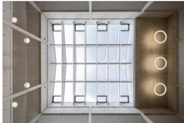
Ein ausgeklügeltes Sonnenschutzraster sorgt für eine optimale, blendfreie Tageslichtnutzung.
