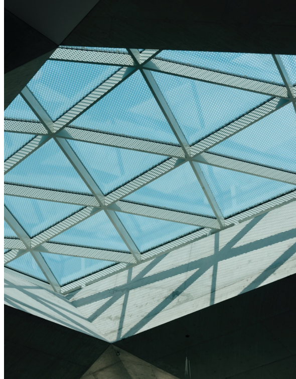
Okalux_Deichman-Bibliothek_©Einar_Aslaksen_03 Die OKATECH Metallgewebeeinlage im SZR setzen optische Akzente und erfüllen dabei hohe Sonnen- und Blendschutzanforderungen.
